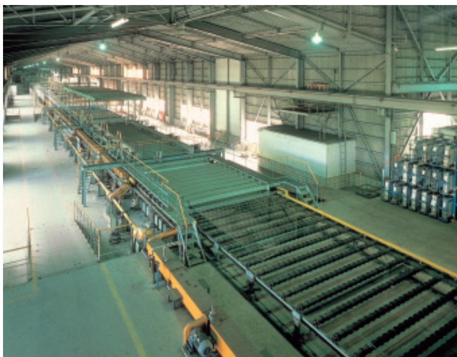
フロート板ガラス製造ライン
