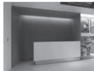
重ったるくになりがちな三方を赤に囲まれた空間を、軽やかかつ立体的に見せるため、カラーガラス製のコンシェルジュデスクを照明装置として位置づけ、そこから光が上面と側面に放たれるように計画。机上面と側面にシームレスラインを仕込み、その部分だけカラーガラスに透明加工を施し、その裏側を乳白アクリルとすることで、鮮やかな光のラインを赤の壁面と天井に映し出すことに成功している。メンテナンス性も考慮に入れられた複雑な照明部分の納まりこそが、この空間全体における色気創出の陰の立役者なのだ。
